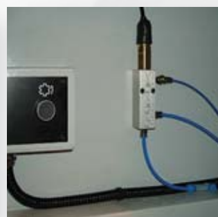
Le petit tube est relié à un commutateur de sécurité basse pression.
